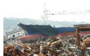
震災発生から約2ヶ月経つが漁港周辺では、陸に乗り上げた漁船もそのままとなっている
